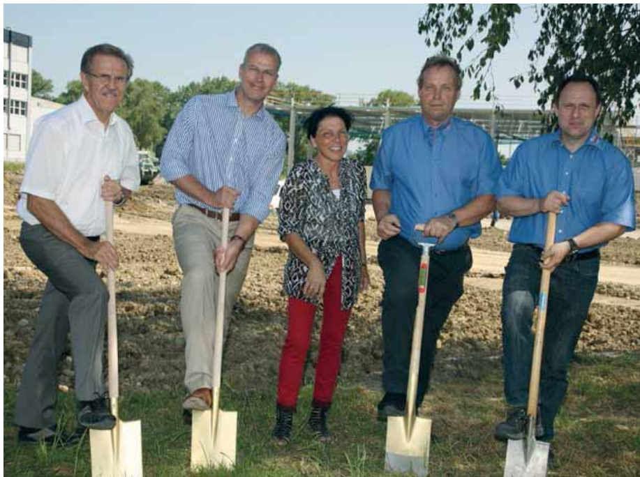
Spatenstich für den Neubau der Firma Kurt Gautschi Fensterbau AG mit illustren Gästen: (von links) Wolfgang Serowy, Geschäftsführer der profine Schweiz AG, Peter Mrosik, Eigentümer und geschäftsführender Gesellschafter der profine Group, Marlies und Kurt Gautschi, Robert Fuchs, stellvertretender Geschäftsführer der Gautschi Fensterbau AG.
